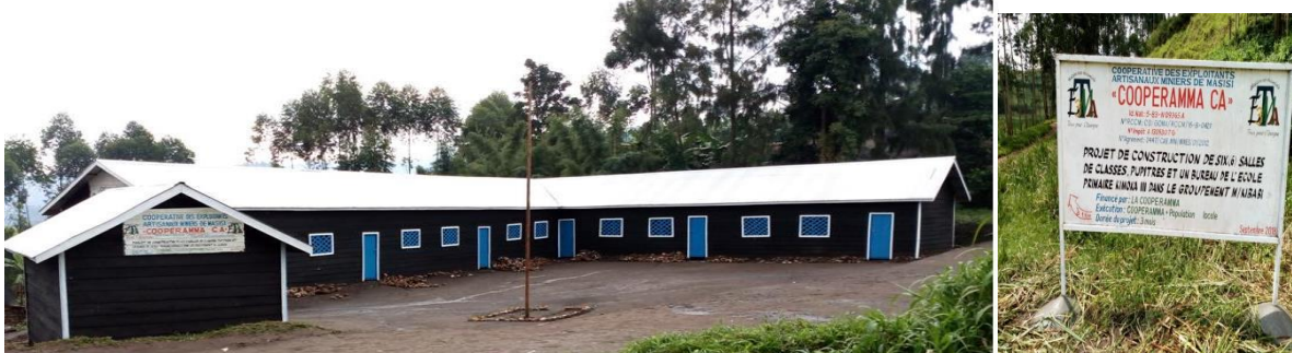
Projet de construction de 6 Salles de Classes et un bureau de l'EP KIMOKA III à BIHULA dans le Groupement M/ KIBABI
